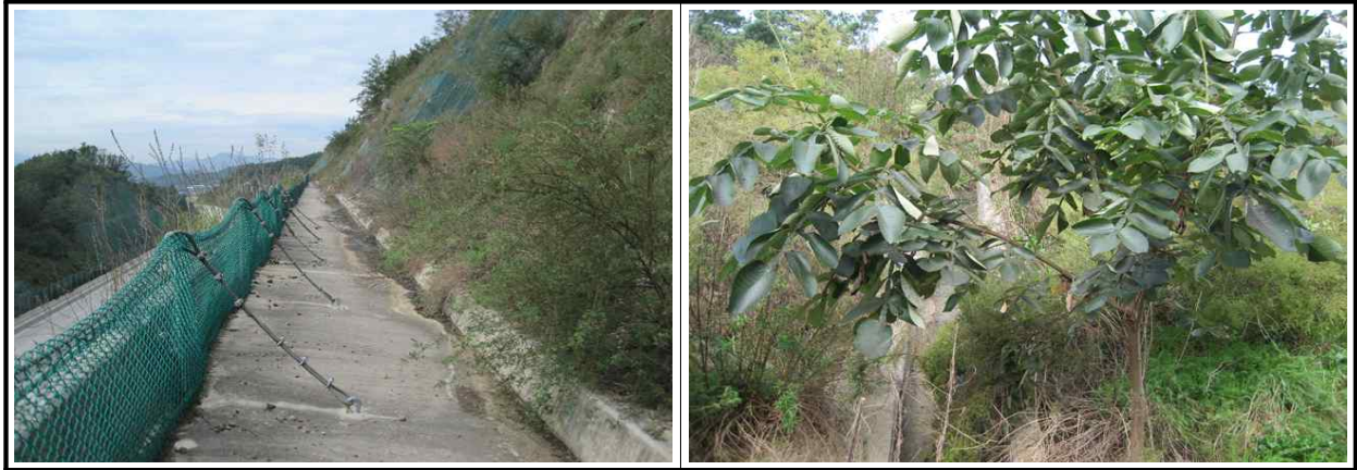
【그림 9.3.3】 배수시설 전경
